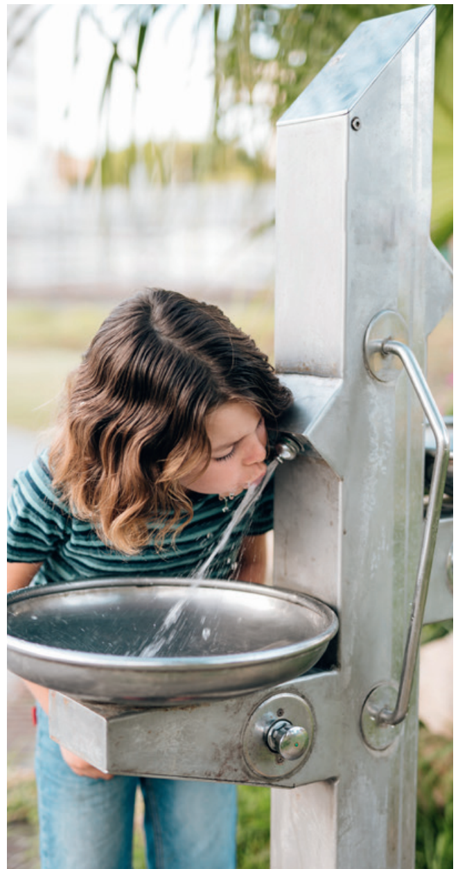
So geht Durst löschen: Kostenloses Trinkwasser aus dem Brunnen – bald auch in Eppendorf?
