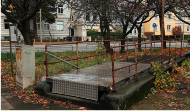
Unter der Metallplatte an der Tarpenbekstraße verbirgt sich Historie
